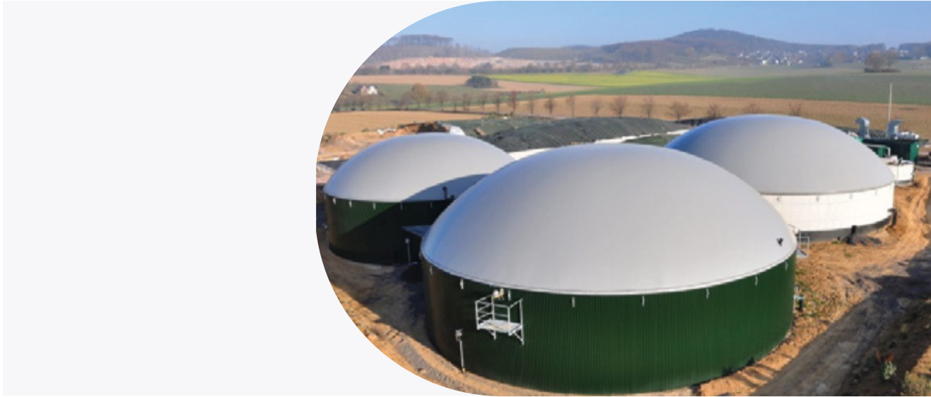
Ilustración 8. Digestión anaeróbica - Biodigestor
