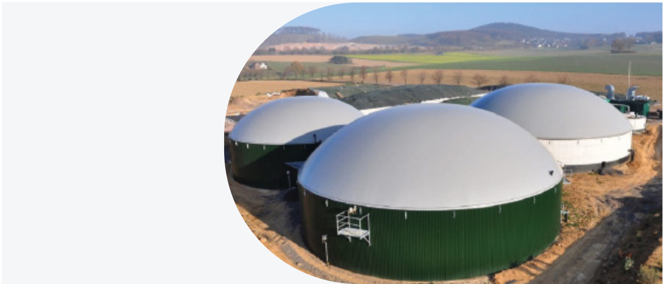
Ilustración 6. Digestión anaeróbica - Biodigestor 2
